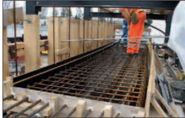
■ Les finitions sont faites sur place avec l'incorporation des câbles de contrainte avant qu'une semelle de béton ne recouvre le tout. Les bordures en demi-cercle finissent élégamment les côtés du viaduc.
