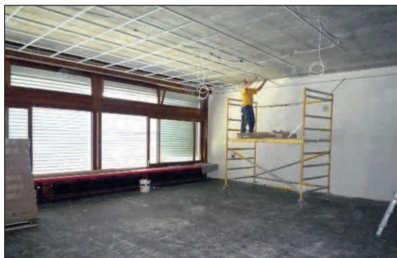
■ Les faux-plafonds ont été intégralement remplacés
