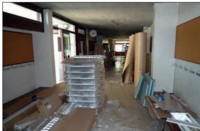
■ Travaux de réfection totale des couloirs ...
