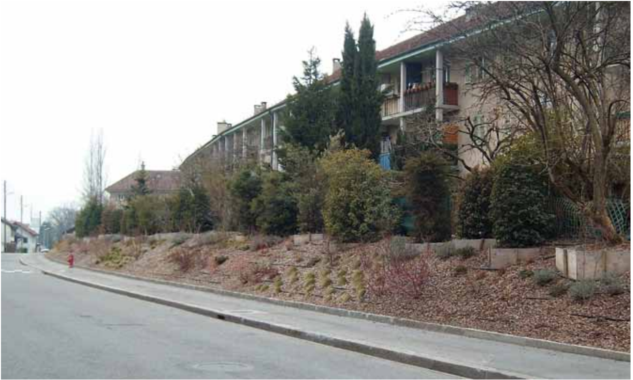
Talus adjacent à un lotissement privé à la rue Virginio-Malnati ▲
