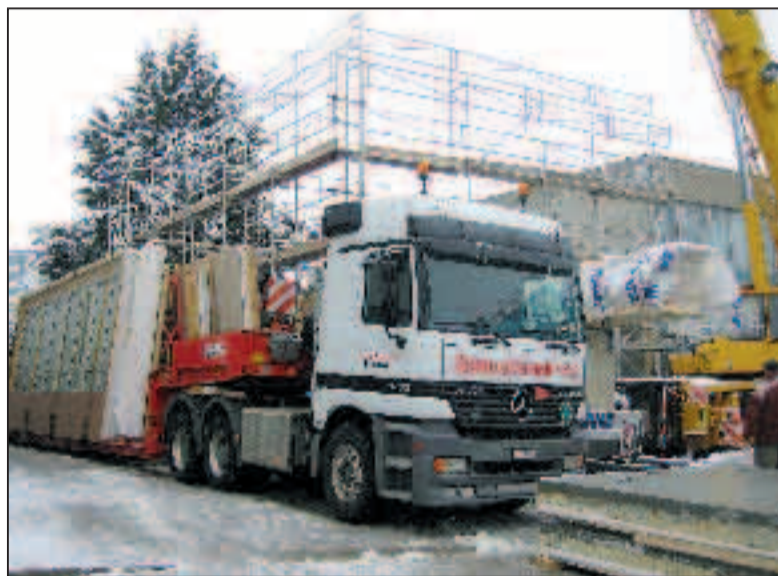
■ Arrivée des éléments préfabriqués.
