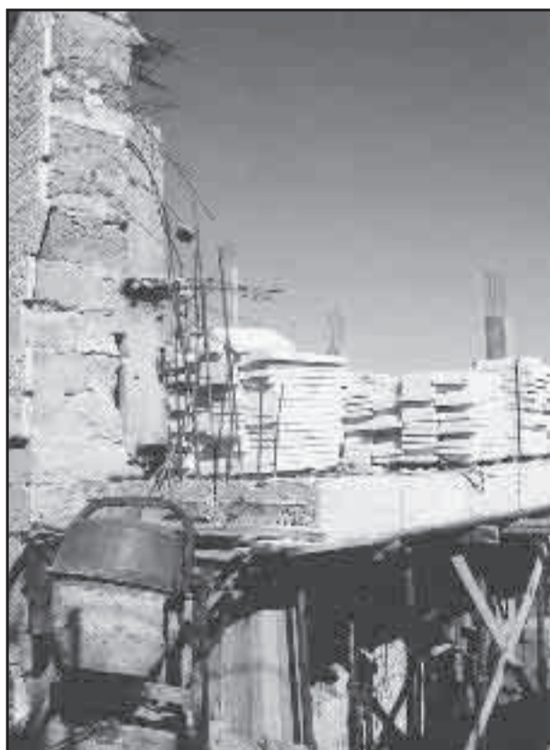
■ Leur maison en construction.
