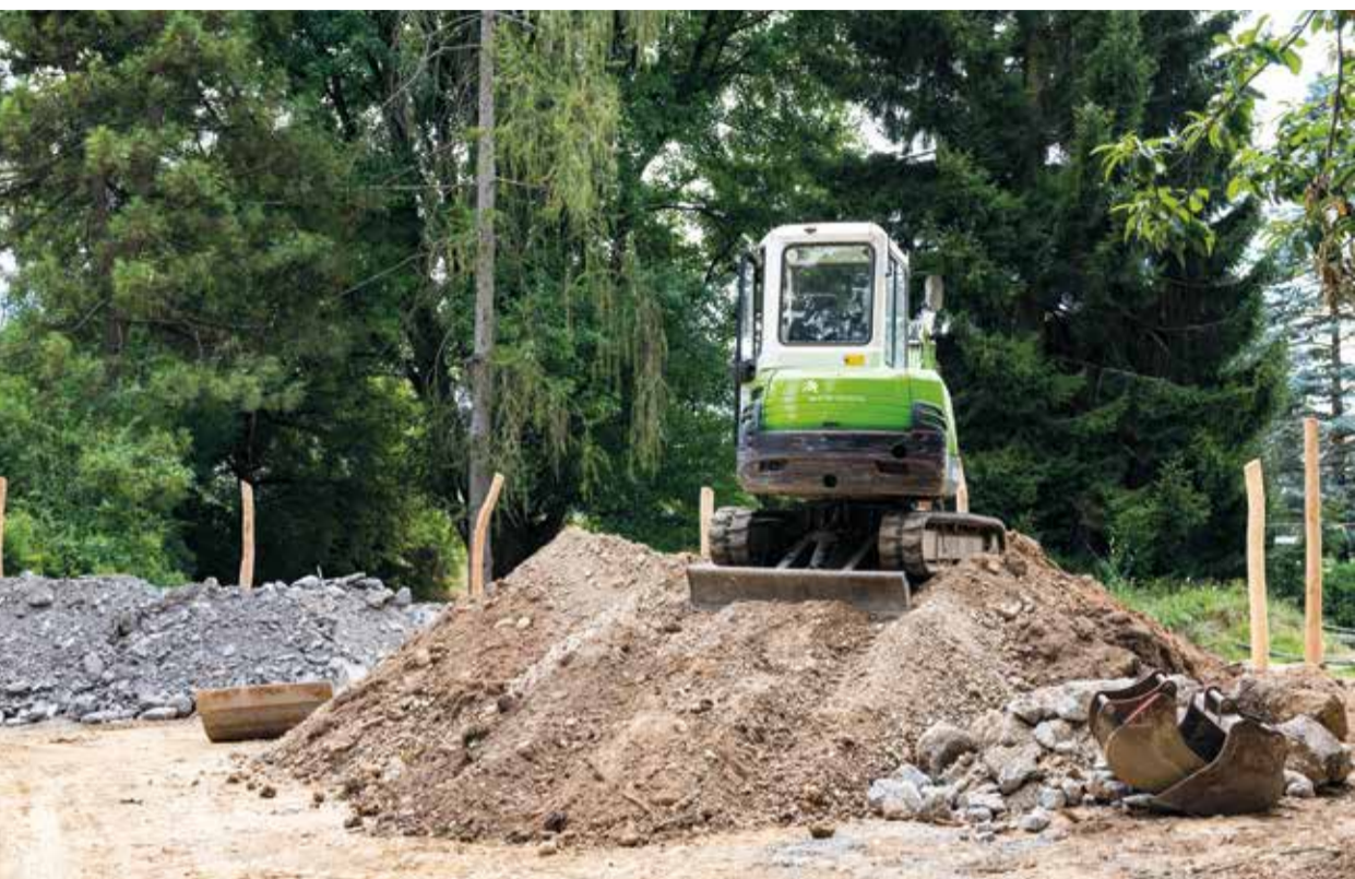
Les travaux du Jardin Alpin, en attendant de découvrir sa revalorisation.
