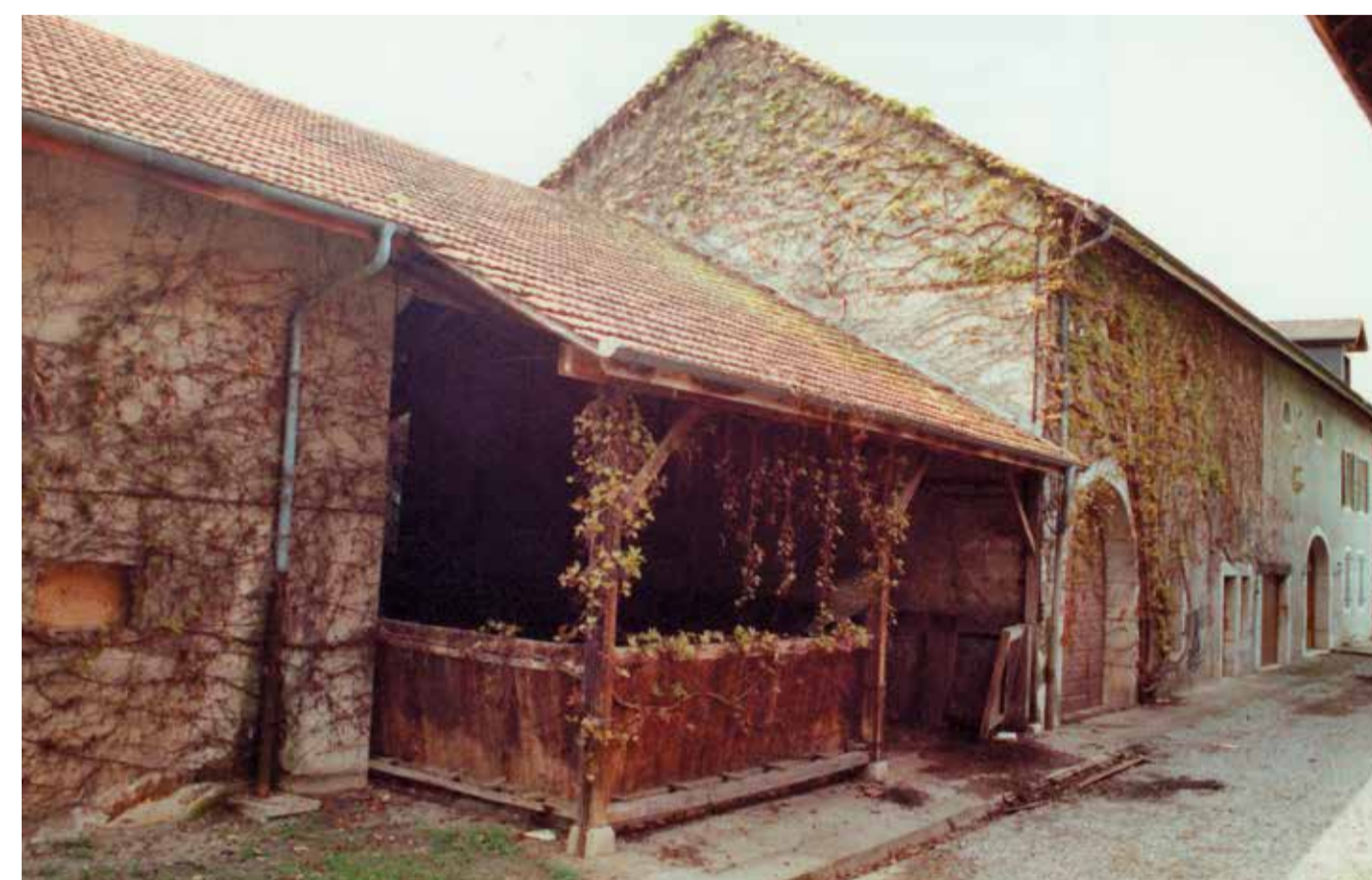
La ferme de La Golette en 1991, avant rénovation © ACM
