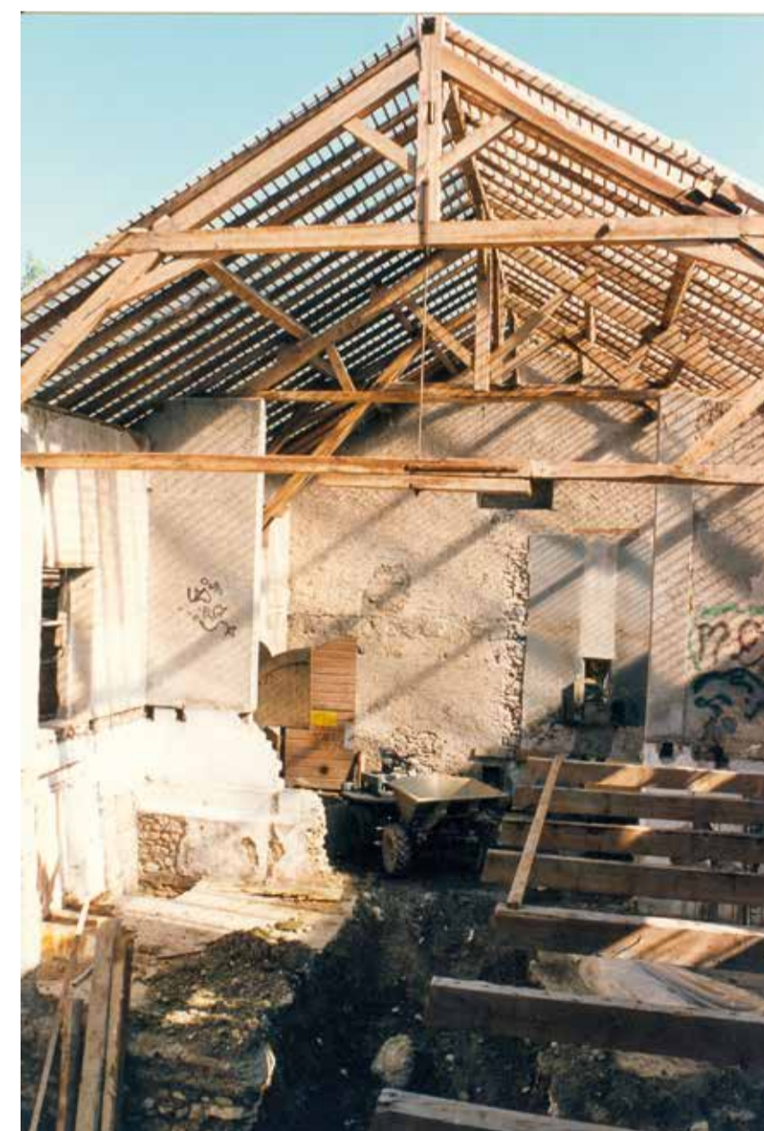
La Ferme de la Golette pendant sa transformation en 1995 © Max Oetti, ACM
