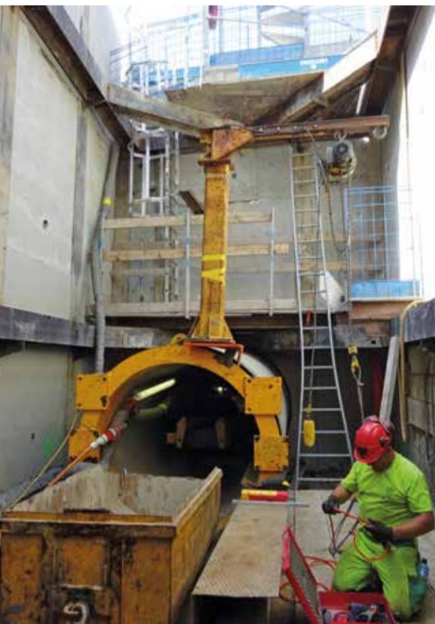
Les travaux du pousse-tube © Pierre Debernard
