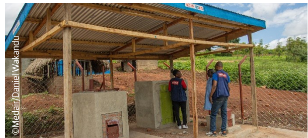
La zone de gestion des déchets (fosse à placenta, fosse à cendres, incinérateur, boîte de broyage, poste de lavage des mains.)
