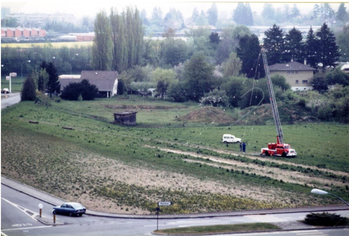
L'emplacement de la future butte lors de la pose des gabarits, 04.05.1982. Photo W. Kubli, ACM.
