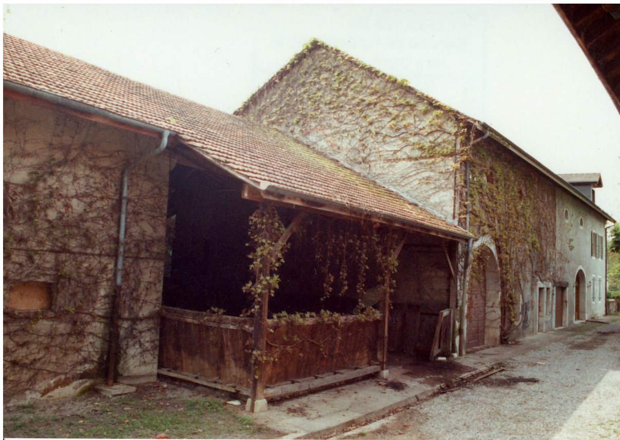
La ferme de la Golette en 1991, avant rénovation. ACM.
