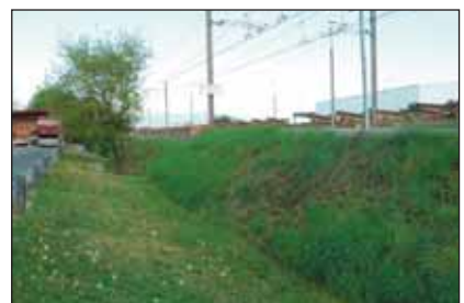
Talus CFF - Zone industrielle
