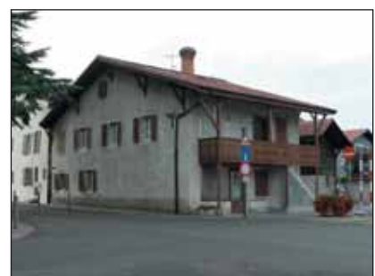
Angle nord ch. du Bournoud, - av. Malnati
